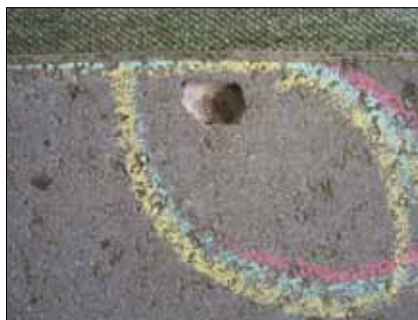
Et hul i overfladen som følge af porøst korn i tilslaget, opstår normalt indenfor det første år.
