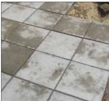
Varierende porestruktur kan give et udseende som dette, når fliserne tørrer ud efter regnvejr. Det er ikke tegn på manglende modstandsevne over for påvirkninger fra frost/tø og salt.
