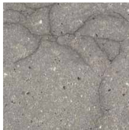
Eksempel på alkalikiselreaktioner, også kaldet "spindelvæv".
