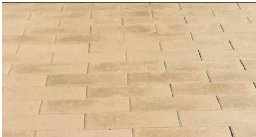
Lader man fugegrus henligge på belægningen, risikerer man afsmitninger, der i værste fald bliver bundet af kalkudfældninger.
