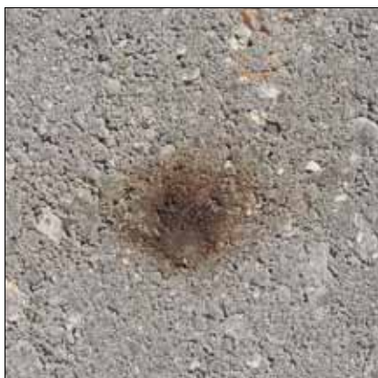
Forskellige former for jernudfældninger. Nogle typer forsvinder med tiden, andre gør ikke.
